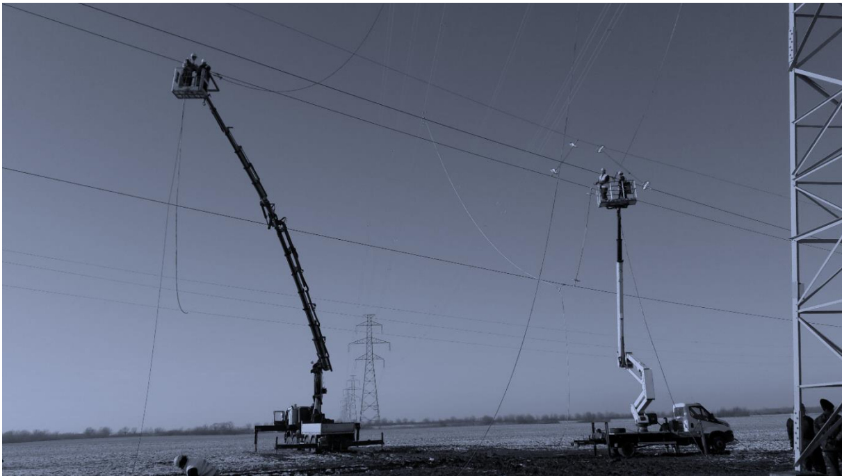
Slika 1: Izvođenje radova na prevezivanju dalekovoda
