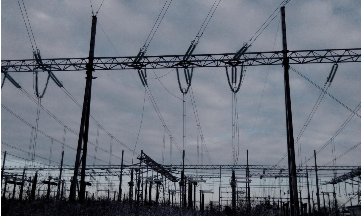
Slika 4: Usklađivanje redosleda faza na portalu C5 u TS Pančevo 2
